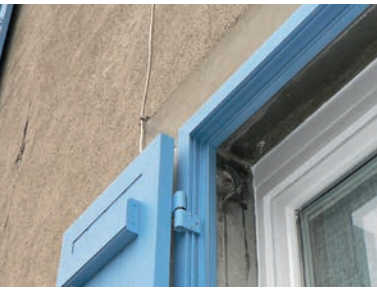
Profil de finition avec joint adaptable qui masque le jour autour de la menuiserie.
